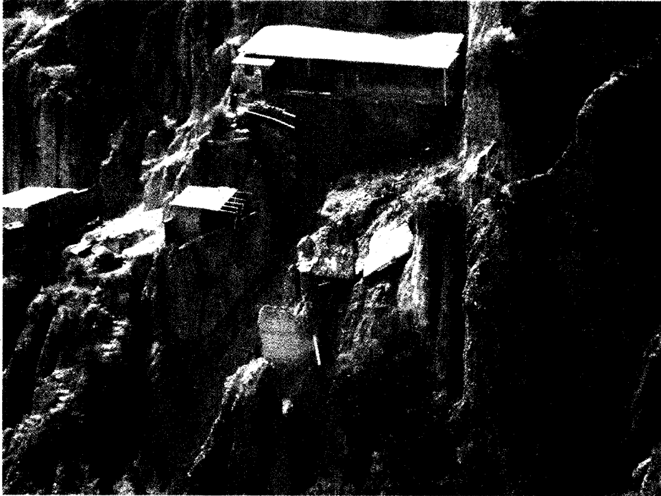
1. Viviendas en el macrodistrito de Cotahuma, Asentamientos ilegales, con conexiones clandestinas de alcantarillado sanitario y pluvial, construcciones en terrenos deleznales y erosión superficial
