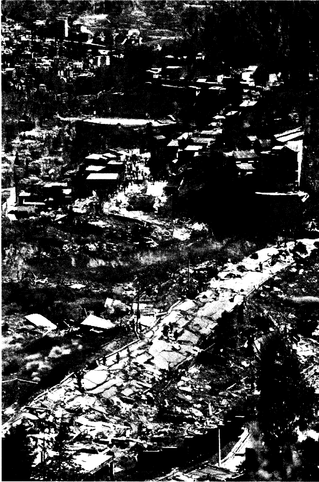
3. Megadeslizamiento de Callapa - Febrero 2011 Los efectos del Cambio climático con precipitaciones pluviales más intensas vuelve más vulnerable a la ciudad de La Paz.
