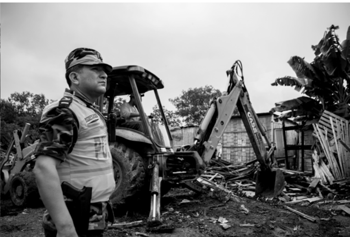
Fotografía: Andrés Loor
