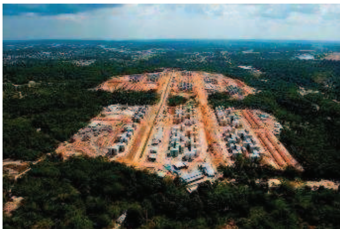
Figura 33 - Residencial Meu Orgulho – Manaus/AM (foto parcial) - 2012
