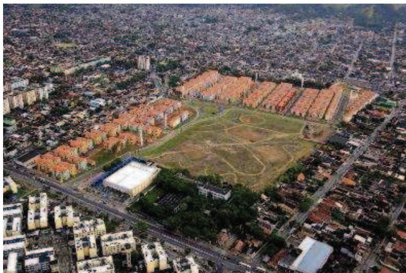
Figura 34 – Exemplo de empreendimento do MCMV – FAR inserido na malha urbana - 2011
