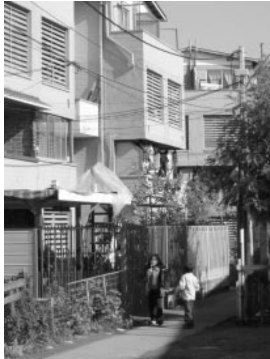
Vista de los departamentos desde el patio central.
