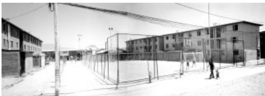
Mamiña II. La fachada posterior de los edificios es frente del espacio público
