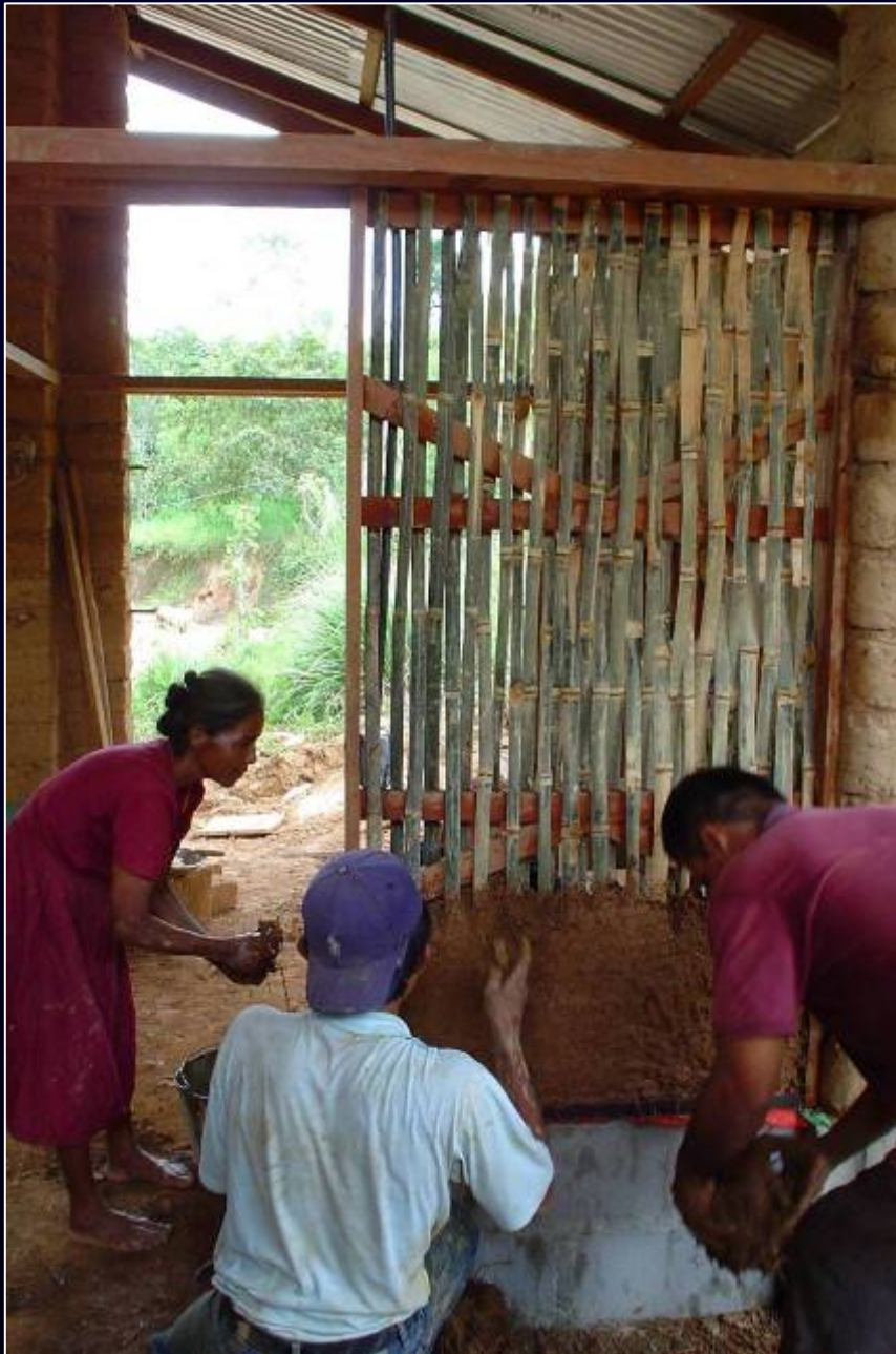
Etapa 2 : muros de relleno en adobe y bahareque.
