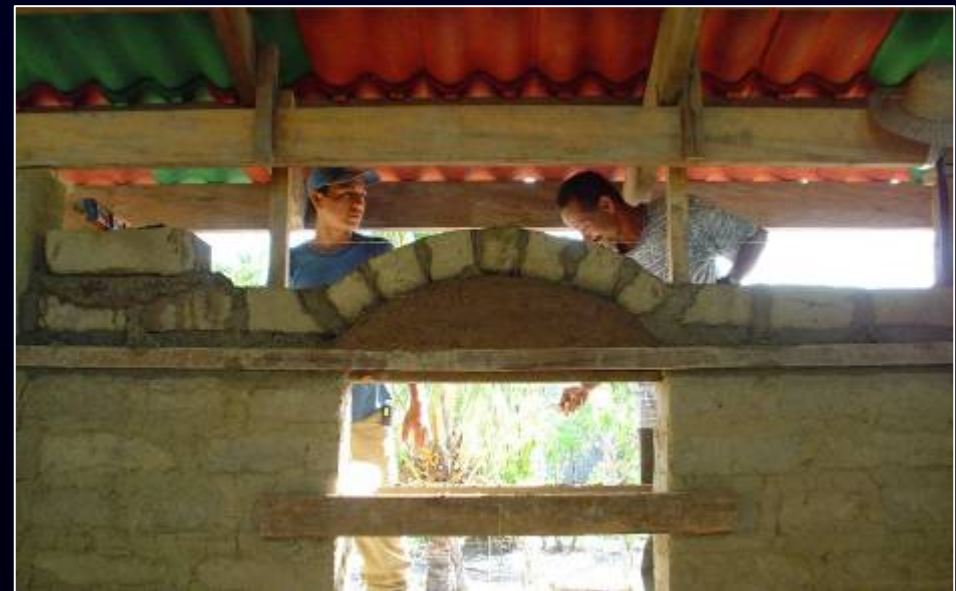
Etapa 2 : muros de relleno en adobe y bahareque.
