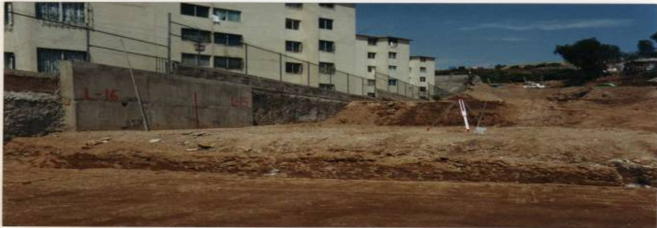
COMPACTACION CON DIVERGACION DEL TERRENO (MURO DE CONTENCIÓN).
