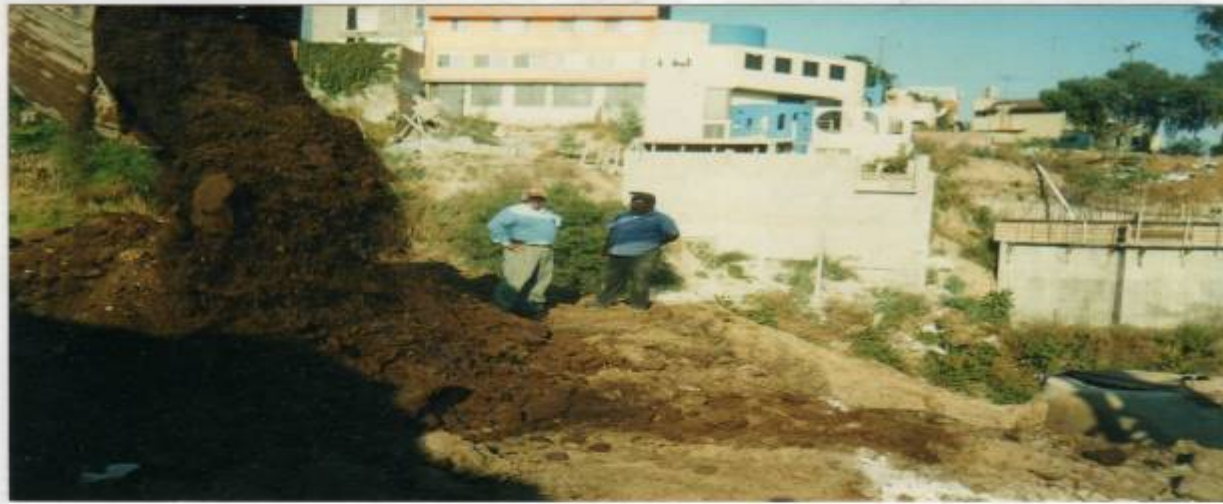
FORMACION DE TALUD COHINDANCIA BARRANCA
