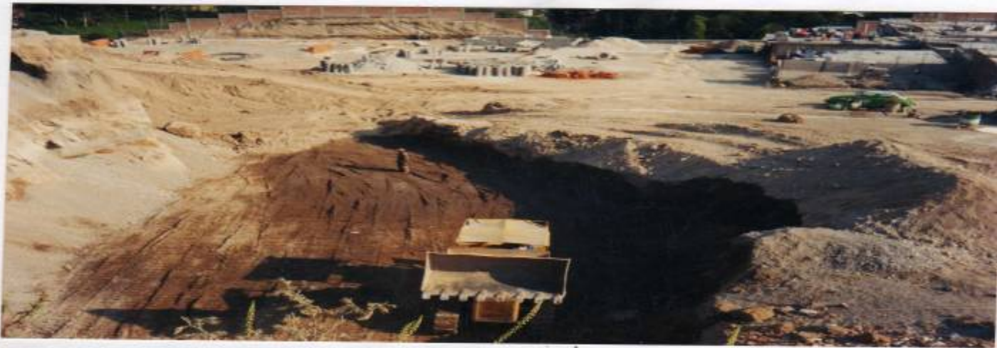
EXCAVACION Y NIVELACION EN ZONA ALTA DEL PREDIO PARA ACCESO PRINCIPAL.
