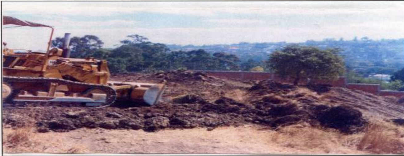
Inicios de trabajos, Despalmes.
