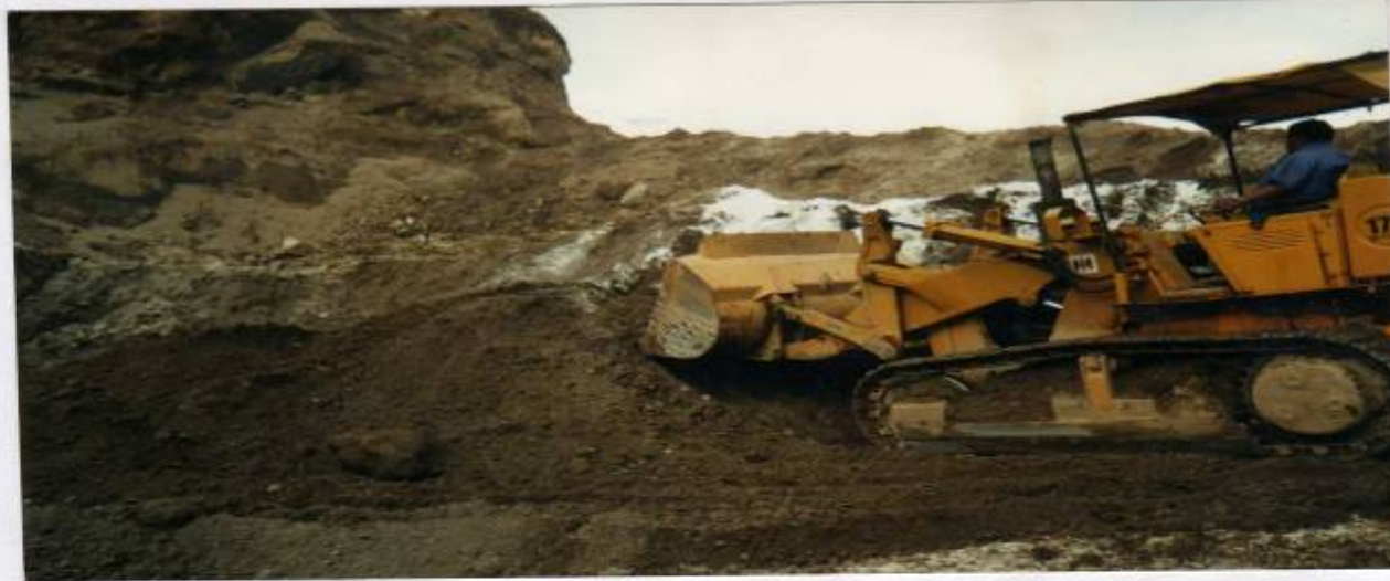
MEJORAMIENTO DE SUELO CAL MEZCLA CON TERRENTOS CAL Y AGUA PARA CARPETOS
