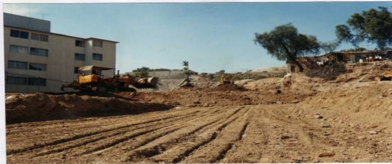
MEJORAMIENTO DE SUELO CAL MEZCLA CON TERRENTOS CAL Y AGUA PARA CARPETOS
