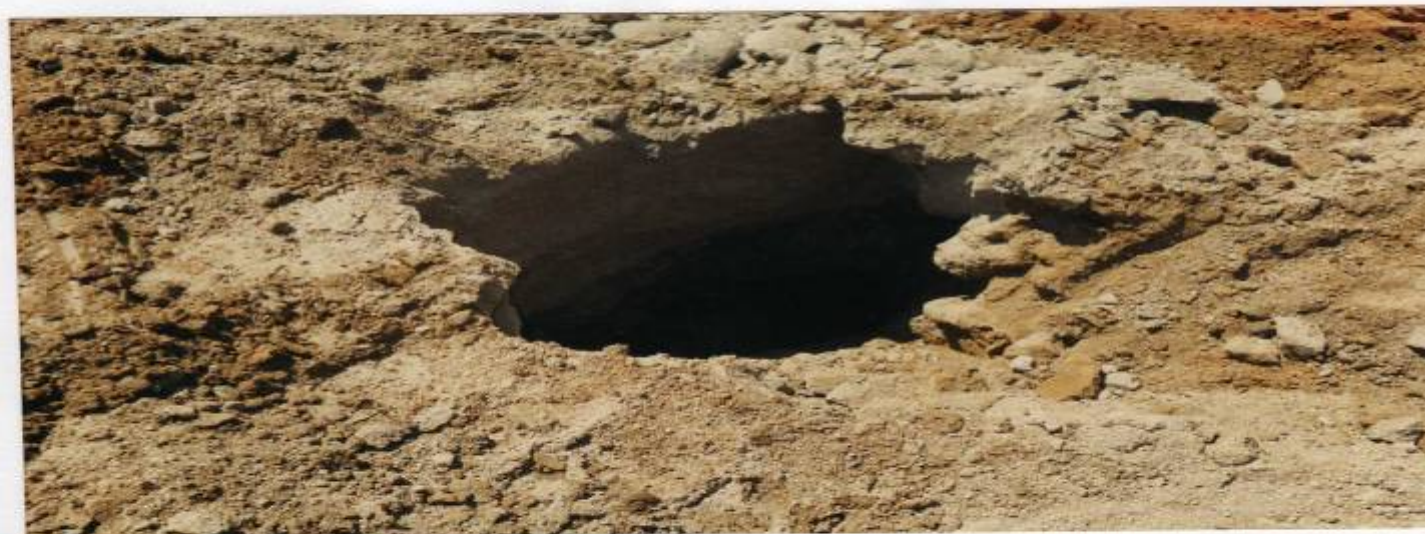
Boca de HINA A FLORE DE SUELO.
