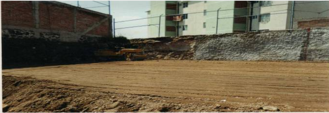
COMPACTACION DE CARPETEOS.
