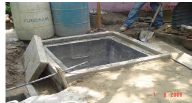
Caja de AN terminada en Comunidad Los Nardos, Soyapango
