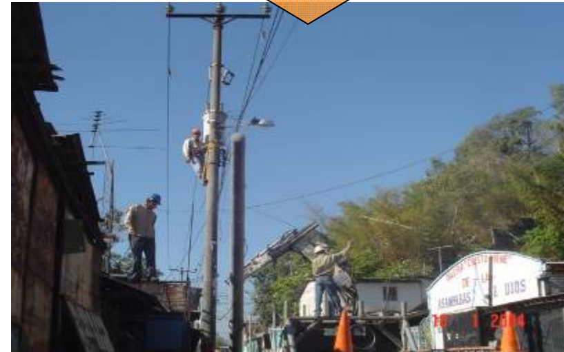
Mejoramiento de redes en Comunidad Quiñónez Privado, San Salvador
