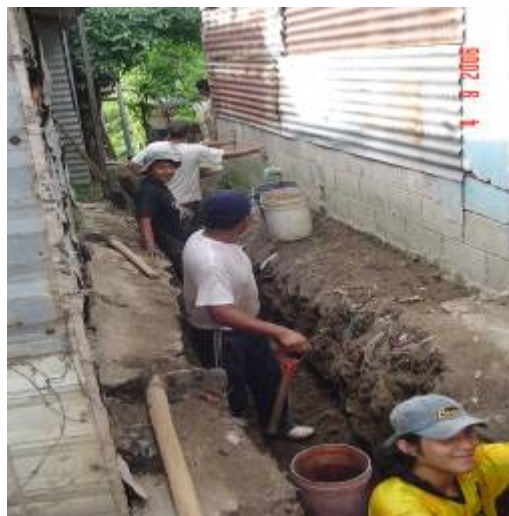
Excavación zanjo para tub. de AN Comunidad 24 de Julio, Mejicanos
